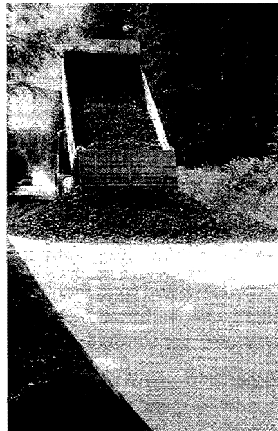
Dämmung gegen Frostaufbrüche im Straßenbau 28
